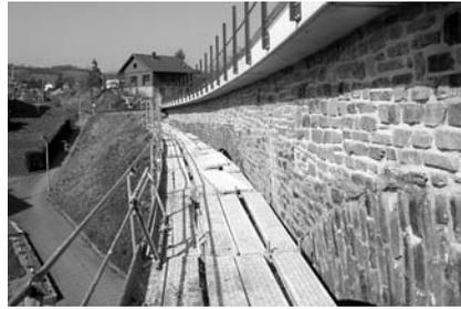
Verblendmauerwerk vor dem aufgesetzten Betontrög am 22.04.2006 (Foto: M.Haubner)
