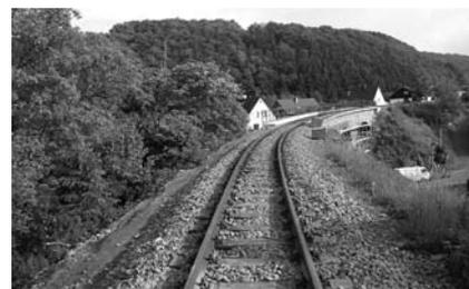
Berichtigte Gleislage und fertig hergestelltes Schotterprofil am Abend des 03.06.2006 (Foto: M.Haubner)
