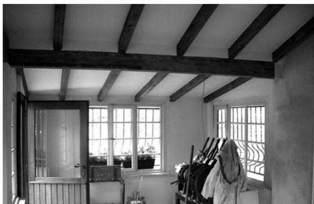
Neue, isolierte Dachdeckenkonstruktion über dem Stellwerksanbau
