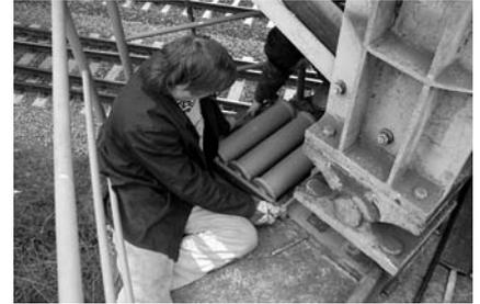
Einsetzen des neuen Rollenlagers durch M.Haubner und J.Dhillon am 07.04.2006
