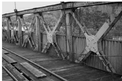
Verstärkte Knotenbleche im Brückenfachwerk am 05.12.2005
