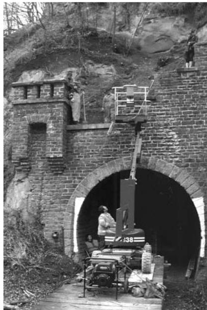
Tunnel Burgbrohl. Freischneiden und Freiräumen des talseitigen Tunnelportals mit Hilfe eines Hubsteigers (Foto: M. Baaden)
