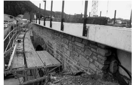
Verblendmauerwerk vor dem aufgesetzten Betontrög mit den beiden Leerrohren für die Signalkabel und teilmontiertes Geländer
