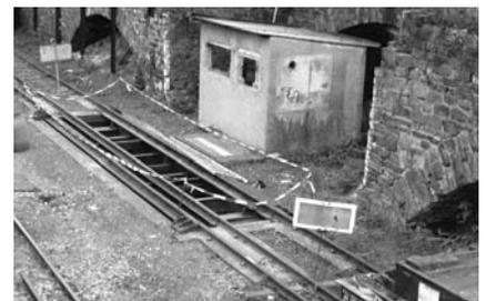
Gehört noch nicht zum alten Eisen: die Gleiswaage (Foto: M. Baaden)
