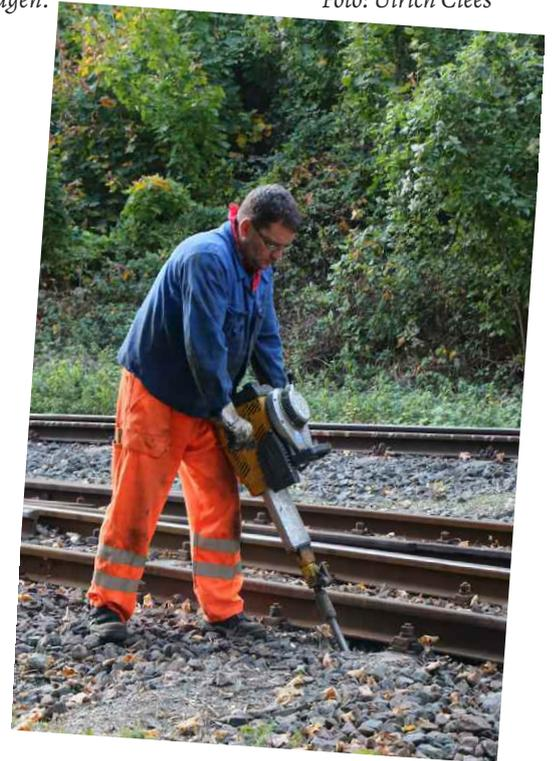
▲ Stete Infrastrukturpflege tut Not: Frank Muth stopft am gleichen Tag mit einer Handstopfmaschine den Schotter im Bereich der Weiche 8 im Bahnhof Brohl BE.
