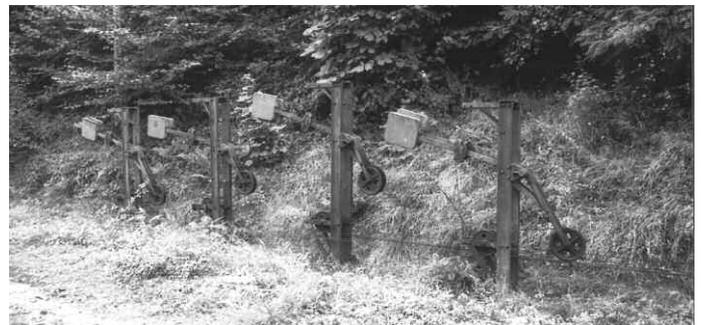
▲ Um die Drahtzüge zwischen der Hebelbank im Bahnhofsgebäude und dem Signal sowie den Weichen stets gespannt zu halten, war auch ein entsprechendes Spannwerk vorhanden.
