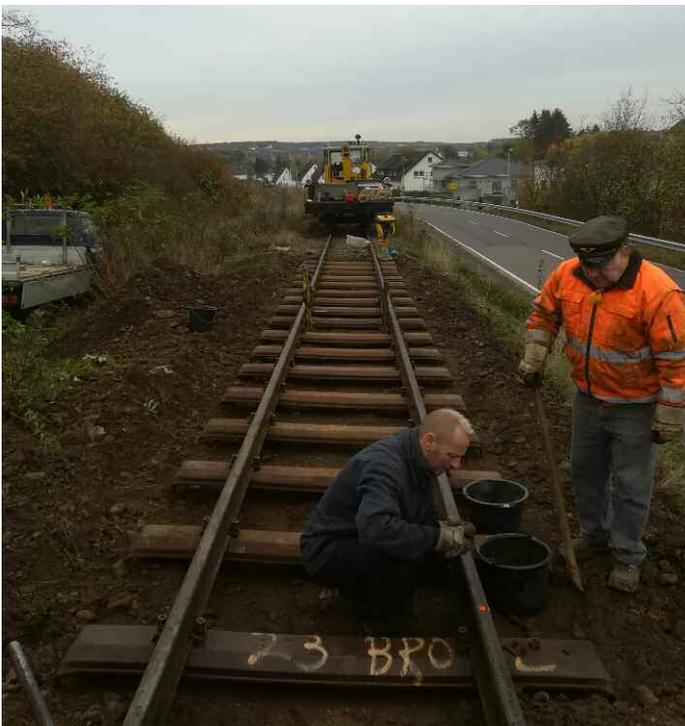
▲ Günther Hündgen und Ralf Merten sind nach dem Einlegen der neuen Stahlschwellen mit der Montage der Kleiseisen beschäftigt.
