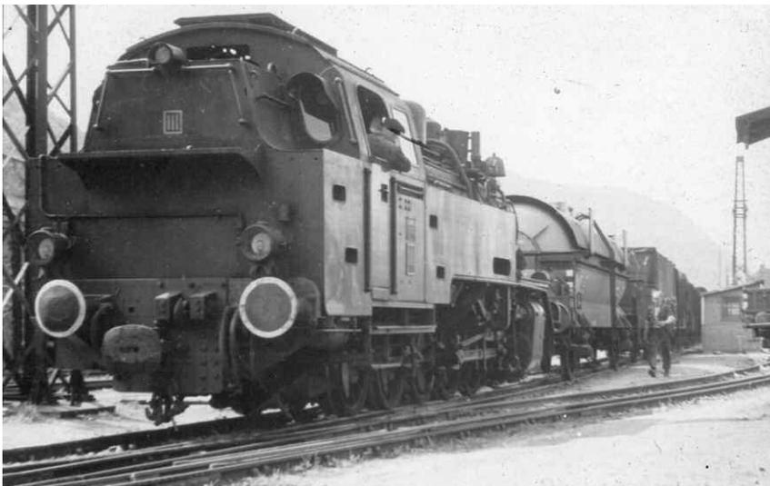
▲ Auch Lok III verfügte über versetzt angeordnete Zug- und Stoßvorrichtungen für Schmal- und Normalspurfahrzeuge. Im Brohler Gbfrangiert sie auf dem Dreischienengleis Normalspurwagen.
