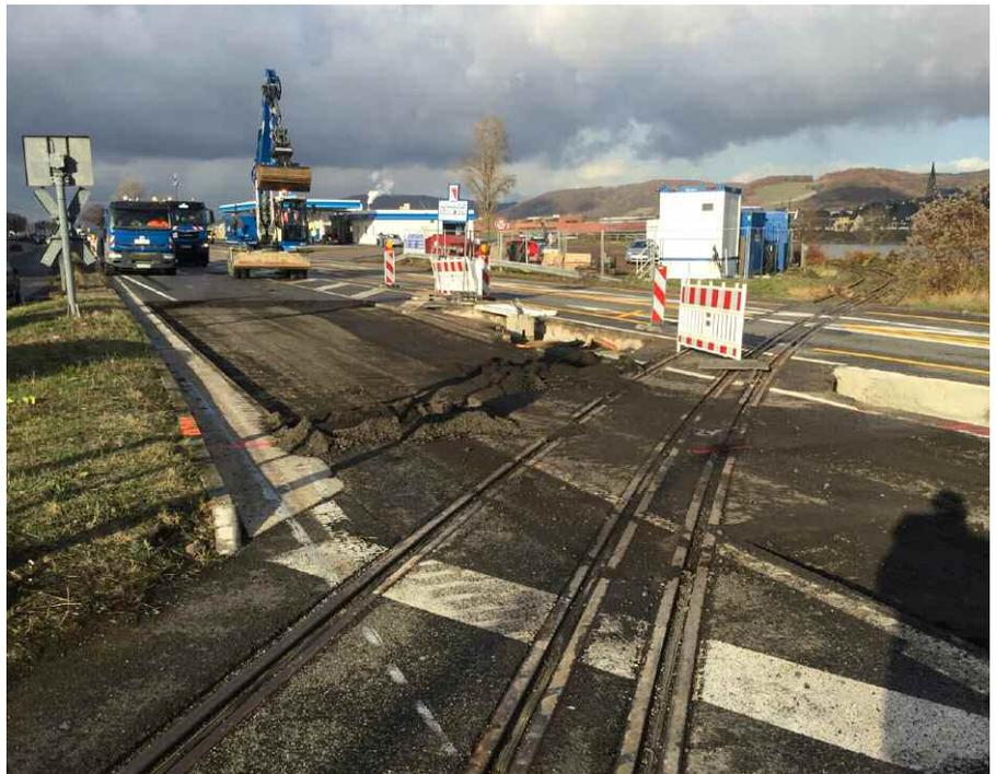
▲ Die südwärts führende Fahrbahn wurde komplett gesperrt und der Straßenbelag entfernt. Im Zuge der Sanierung wurde auch der Bahnübergang mit erneuert.
