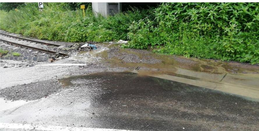
▲ Im Bereich des Bahnübergangs in km 1,0 ist das Gleis geringfügig überschwemmt und mit Sediment bedeckt worden. Größere Schäden waren durch das Starkregenereignis am 14./15. Juli 2021 glücklicherweise nicht zu verzeichnen. Foto: Markus Degen
