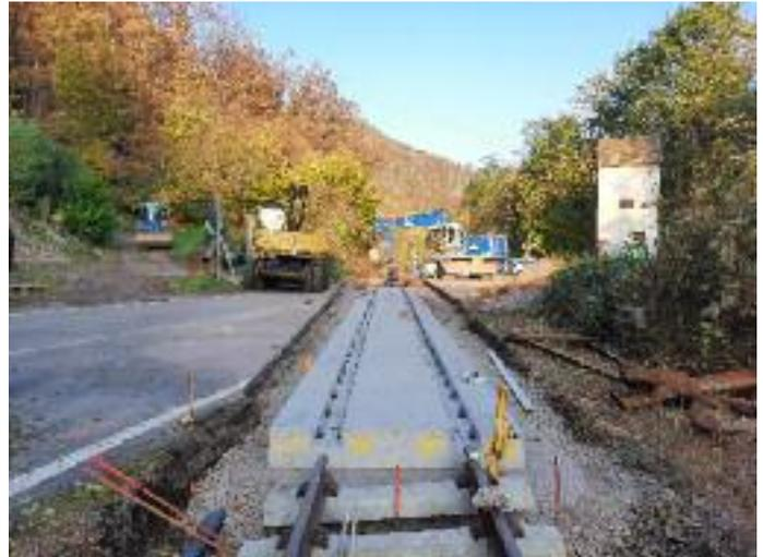
▲ Schon wenige Tage später konnte die Betontragplatte zur Aufnahme der neuen Gleise in den Bahnübergang eingebaut werden.
