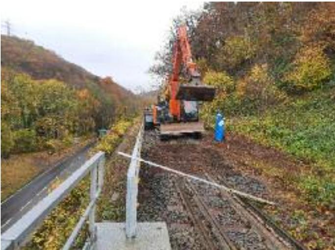
▼ Ausbau der alten Gleisjoche hoch über der B 412 mittels Bagger.
