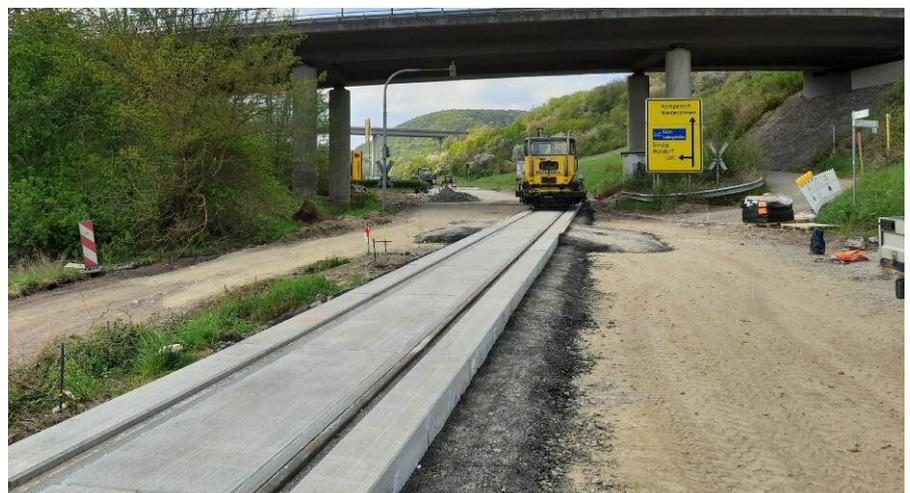
ständig entfernt und eine neue Betontragplatte eingebracht worden. Die bisherigen Schlaglöcher und Unebenheiten in der Straße gehören damit der Vergangenheit an.
