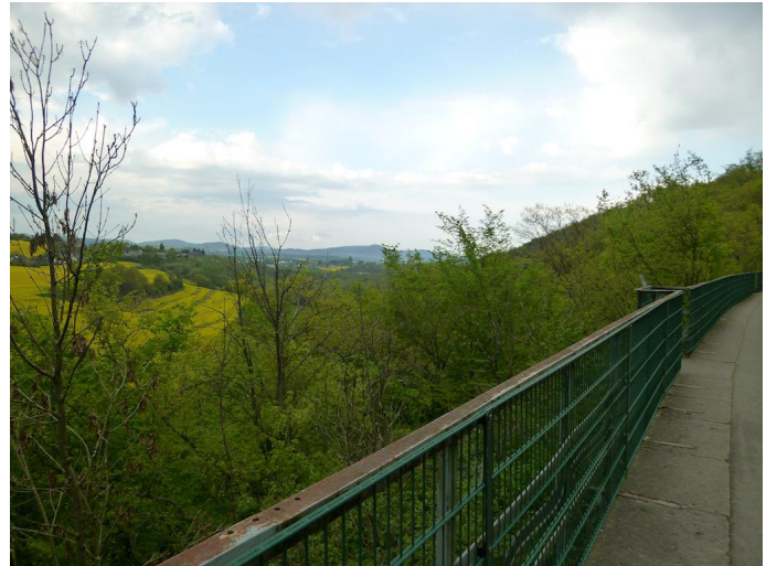
Viadukt auf dem Maifeld-Radweg Autor Michael Hergarten Quelle outdooractive.com-Community
