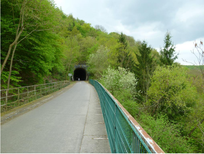
Tunnel statt steil bergauf! Auf ehem. Bahntrassen gehts über das Maifeld. Autor Michael Hergarten Quelle outdooractive.com-Community
