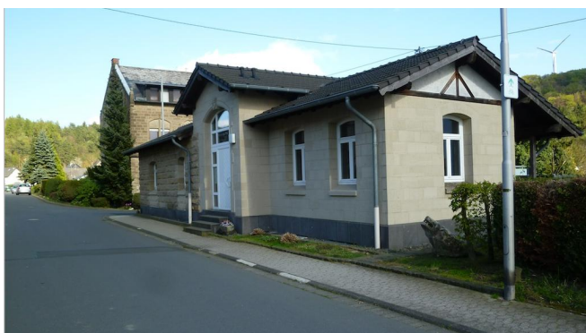
Das ehemalige Bahnhofsgebäude von Weibern wird heute als Steinmetzmuseum genutzt. Foto: Michael Hergarten, Community
