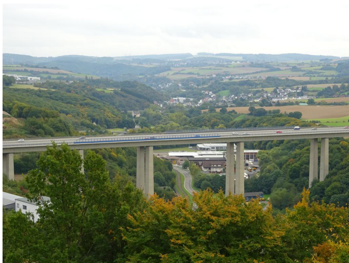
Blick vom Bausenberg in Richtung Burgbrohl.
