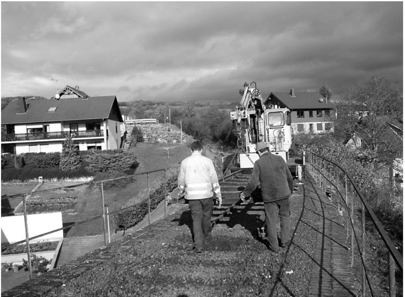
Rückbau der Gleise, auf dem Viadukt mit dem SKL am 2. November 2005
