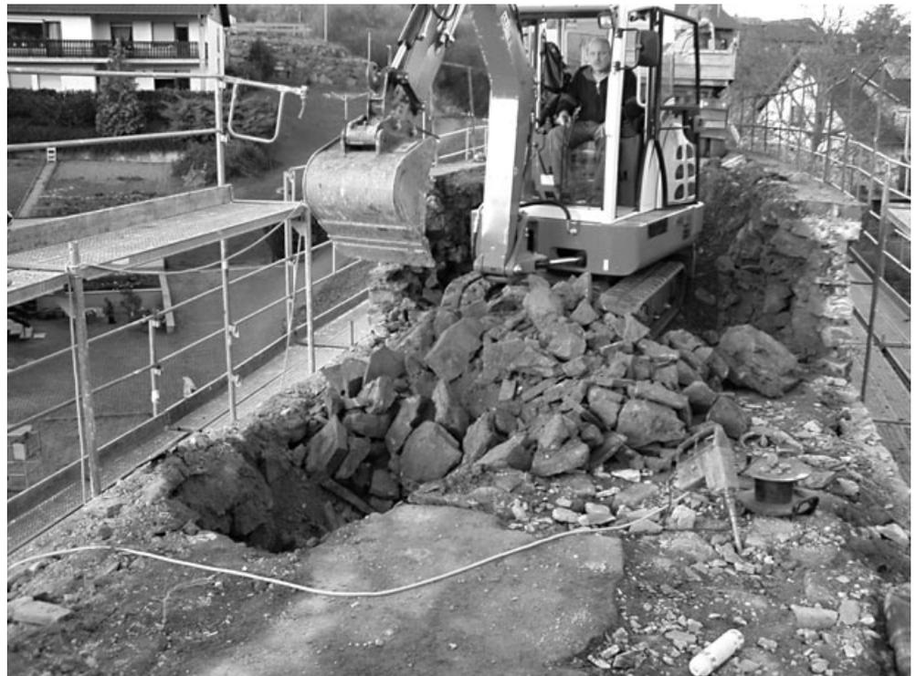
Abbruch der Seitenmauern oberhalb des Gewölbes mit einem Minibagger – 8. November 2005 (Foto: Manfred Schlich)
