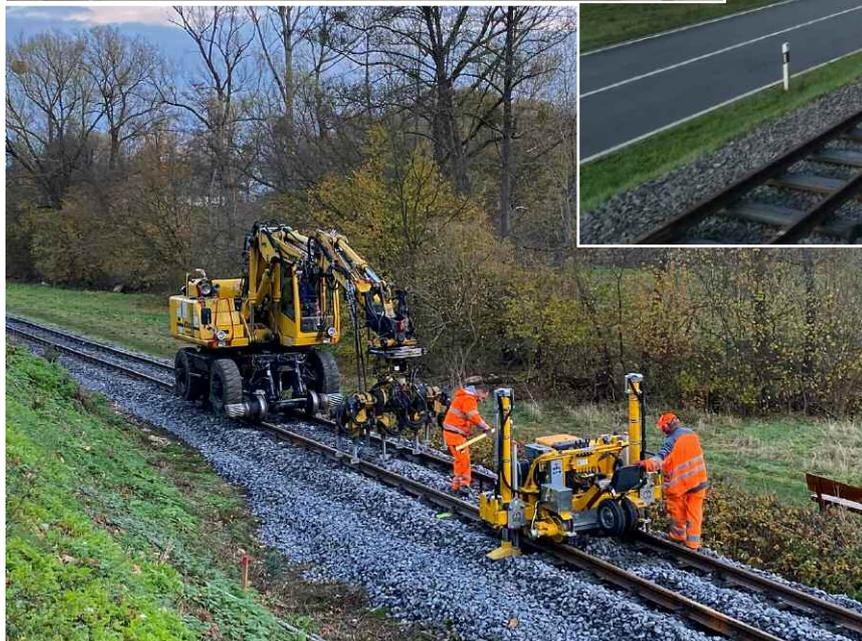
▲ Die Schienen und Schwellen wurden zu fertigen Gleisjochen vormontiert, anschließend verlegt und miteinander verbunden. Unser Skl bringt neue Schienen heran.
