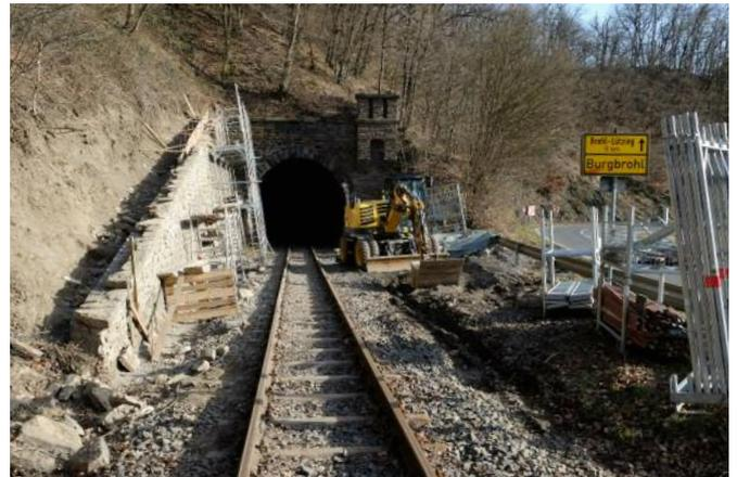
▲ Mitte Februar sind die Portale und Flügelmauern des Tönissteiner Tunnels saniert worden.
