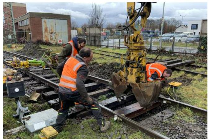
▲ In der Weichenverbindung liegt die Gleissperre 102, die auch neue Schwellen erhielt.
