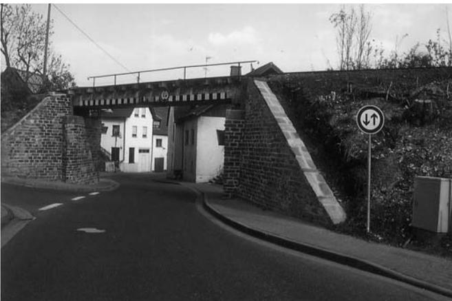
Die durch Lademaßüberschreitung beschädigte Bahnüberführung in Oberzissen wurde repariert und auch das Mauerwerk neu verfugt.
