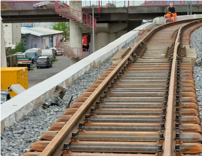
▲ Erste S49 Schienen sind auf den Schwellen montiert. Im Hintergrund ist die Schienenauszugsvorrichtung zu sehen. Foto: Jens Ahlbach
