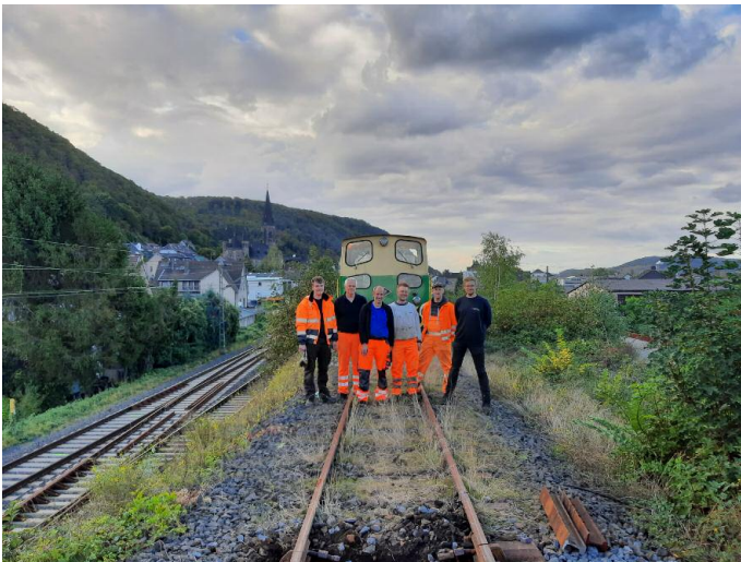
▲ Das berechtigterweise zufriedene Gleisbauteam der IBS nach Durchführung des Lückenschlusses zum Umladebahnhof. Von links nach rechts: Marcel Wachtveitel, Achim Wachtveitel, Jens Ahlbach, Tobias Baaden, Udo Markus Schwenzfeier und Martin Bickenbach.
