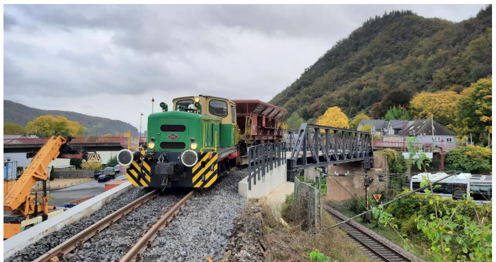
► Lok D1 beim Einschottern mit einem Rollwagen in Vorbereitung der Stopfarbeiten. Foto: Frank Muth
