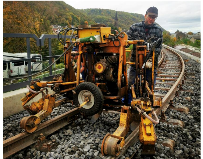
▲ Im Gegensatz zum Stopfen mit Hand-Stopfhämmern erleichtert das gleisgebundene Stopfaggregat die schwere körperliche Arbeit enorm. Im Bild: Frank Muth. Foto: Rafael Wunderwald
