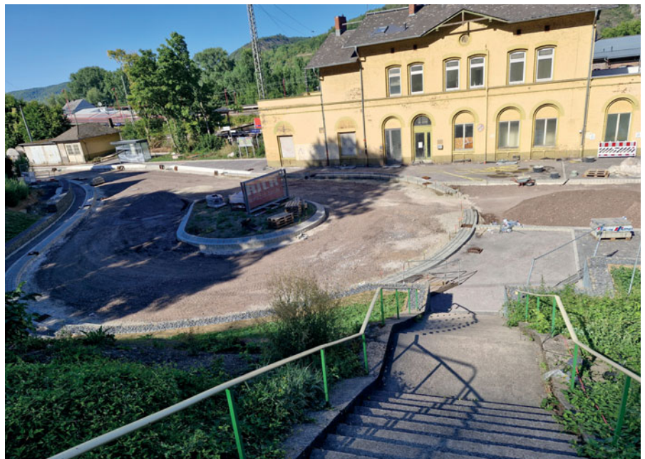
▲ Ein Blick von unserem Bahnhofsaufragang auf den Vorplatz zeigt am 18. August 2025 Fortschritte bei den Baumaßnahmen. Foto: Stefan Raab
