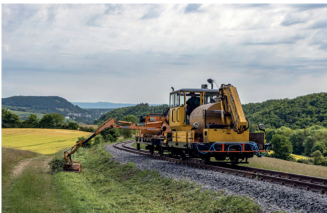
▲ Mäharbeiten im Bereich der frisch sanierten Steilstrecke. Der Mähbalken ermöglicht es, mehrere Meter des Bahndamms zu pflegen. Die blauen Schläuche an der Front des Skl gehören zur neuen Spritzanlage zur chemischen Aufwuchsbekämpfung. Foto: Rüdiger Balhar
