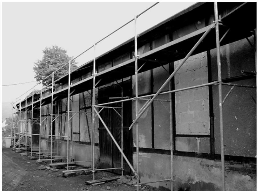
Renovierung der alten Wagenhalle in Brohl. Außengerüst für die Arbeiten an der tragenden Holzkonstruktion und an der Erneuerung einzelner Wandgefache (Foto: Ortwin Wildeman)
