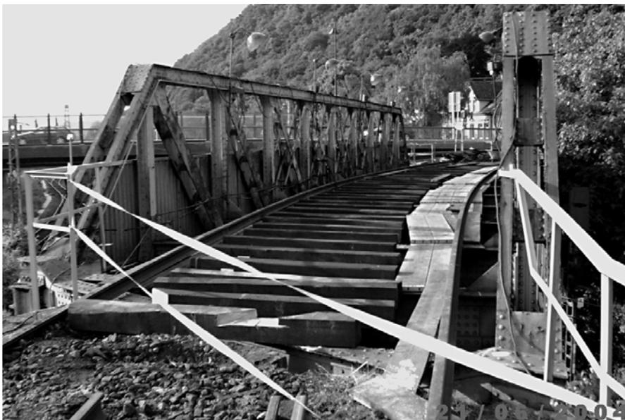
Der Brückenbelag ist komplett entfernt, die neuen Schwellen verlegt (Foto: Stefan Raab)
