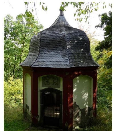
Am Wegesrand liegt ein renovierungsbedürftiger "Weinbergstempel". Foto: Michael Hergarten, Community
